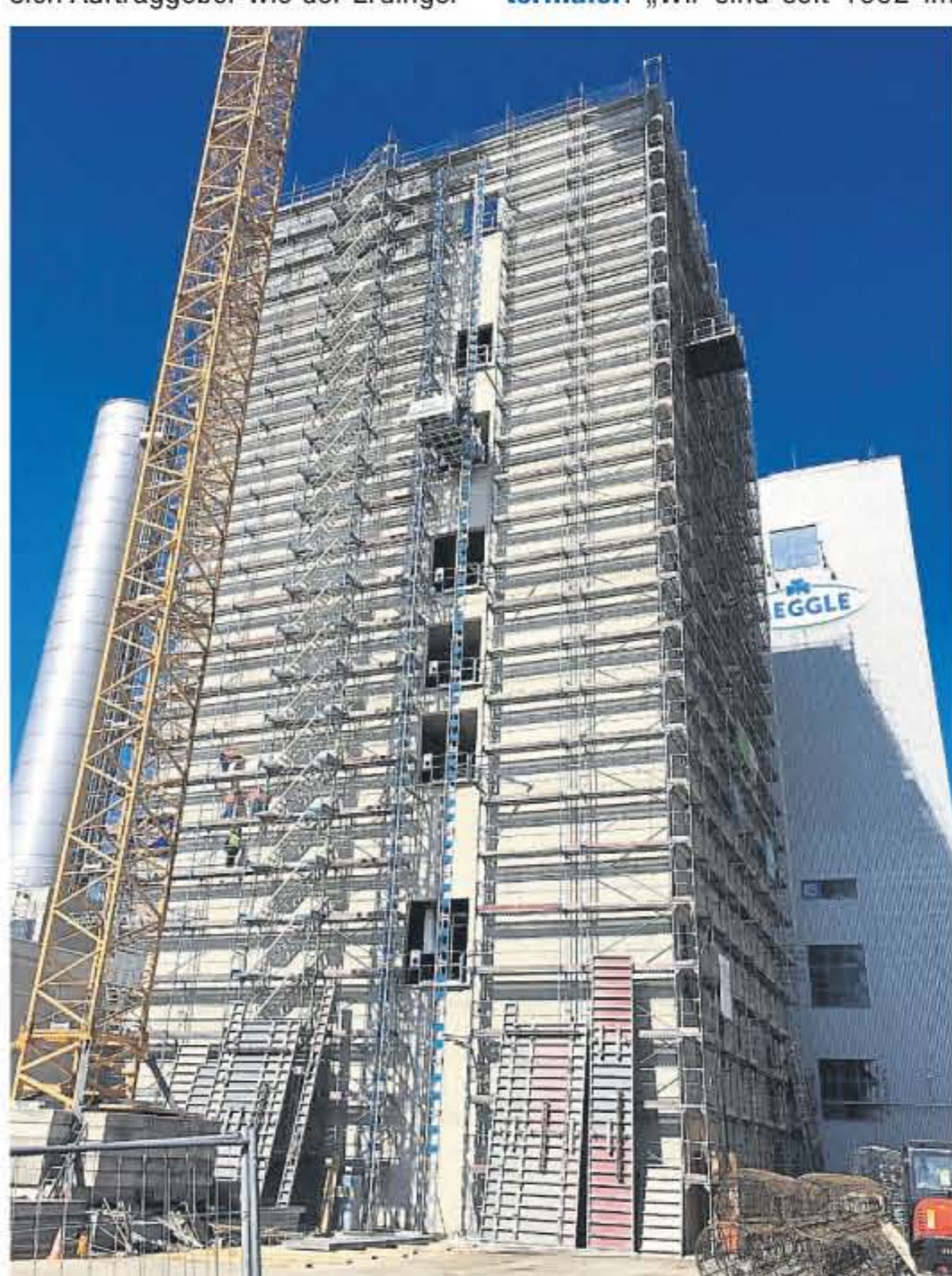
Ein Referenzobjekt ist auch dieser sogenannte Pharmaturm der Molkerei Meggle.
